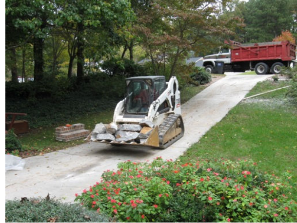
Transport- ing the old concrete.
